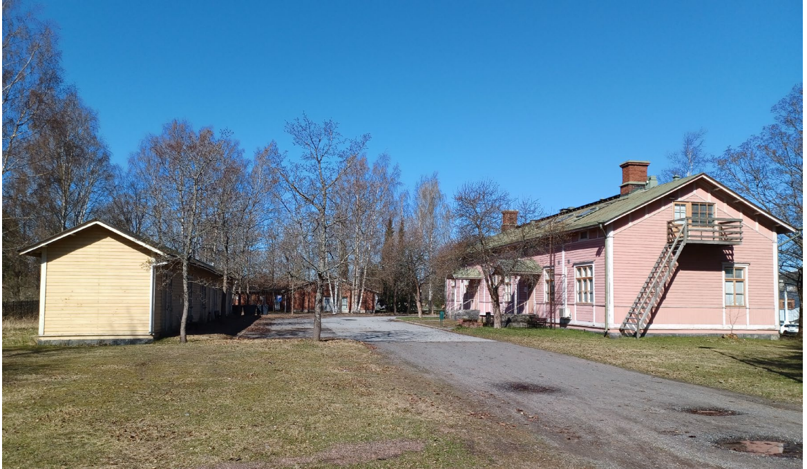
Kuva 2. Suunnittelualueella olevat Porin vanhaan asemakylään kuuluvat rakennukset.
